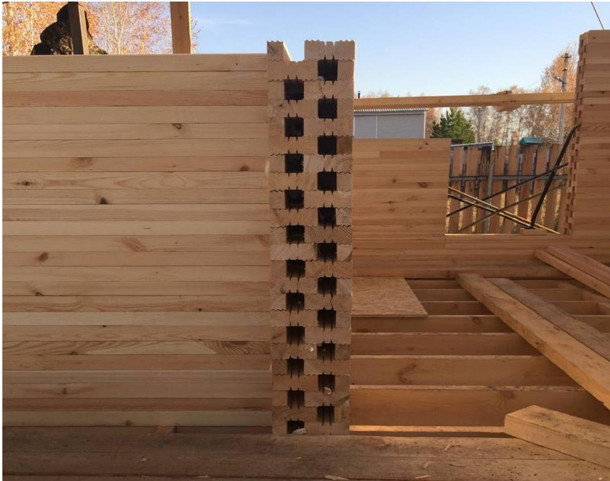
Из этих досок строятся стены ограждающих конструкций таким образом, чтобы каждый слой состоял из узкой доски, широкой доски и пустотного канала между ними, который оставляется пустым, чем достигается значительная экономия материала и существенное снижение теплопотерь. Получается ровно, прочно, надёжно и красиво!
